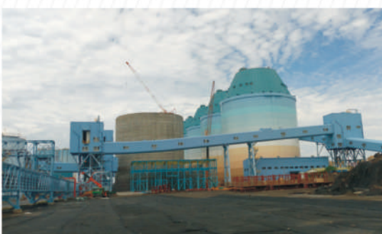
大林電廠 Ta Lin Power Company
