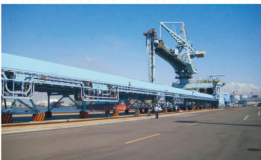
大林電廠 Ta Lin Power Company
