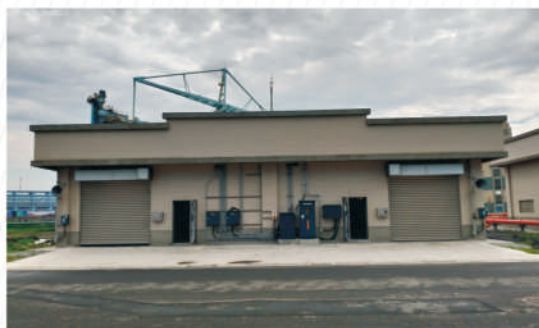
大林電廠 Ta Lin Power Company
