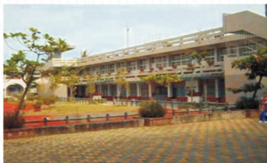
永安國小水電工程 Yongan Elementary School
