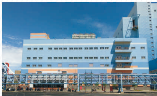
大林電廠 Ta Lin Power Company
