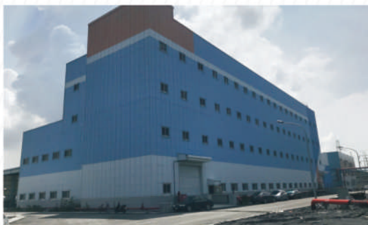
大林電廠 Ta Lin Power Company
