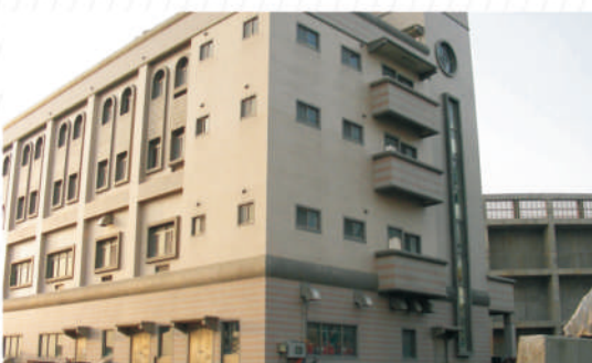
興達電廠煤倉控制室 Shin Da Power Company
